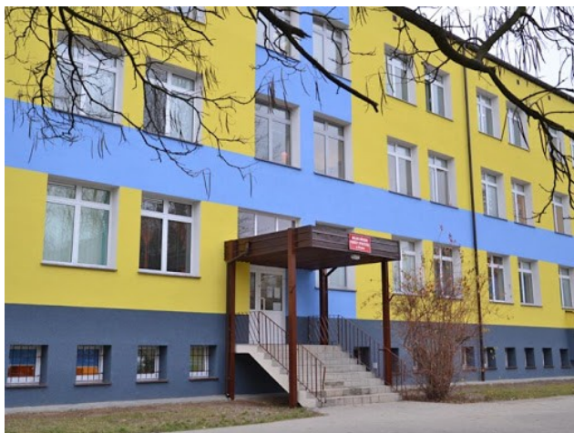
Fot.: Wejście do budynku przy ulicy Zgliczyńskiego
